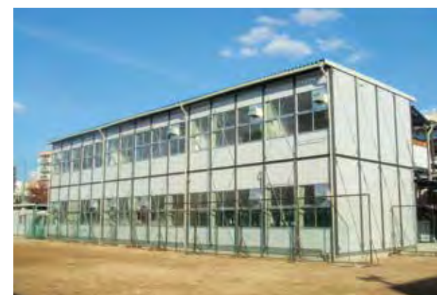
仮設校舎 製品名/スタンダード
