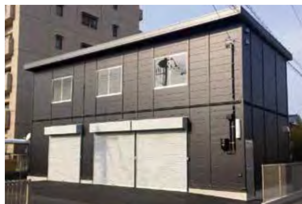
事務所兼倉庫 製品名/スタンダード
